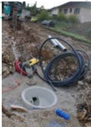
Détournement de la conduite d'eaux usées
