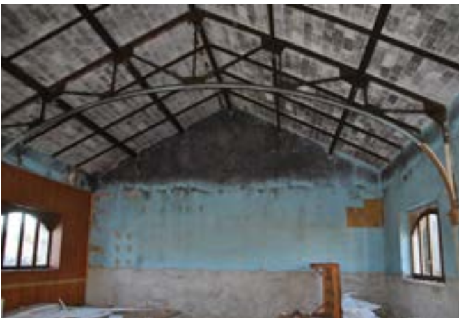
Démontage des plafonds et murs par les agents
