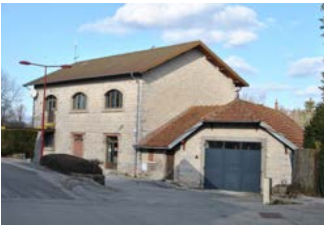
La salle avant les travaux
