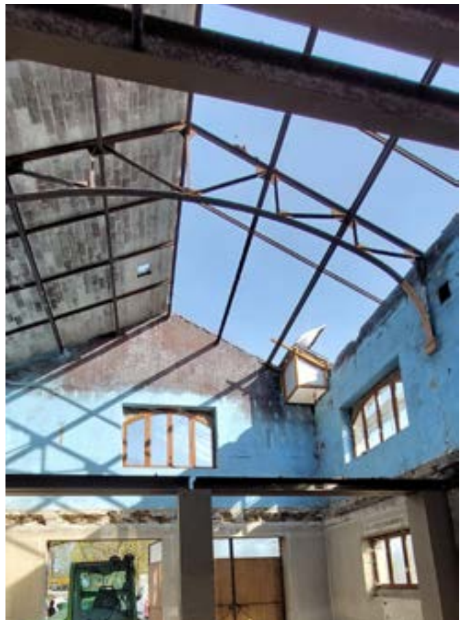
Démontage de la toiture La charpente est préservée et sera visible.
