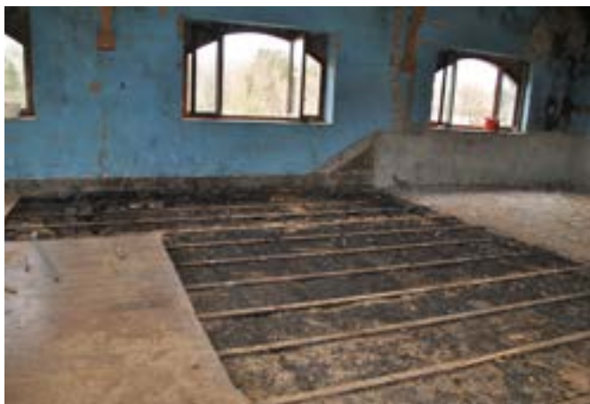
Le plancher est enlevé. Pas de dalle !
