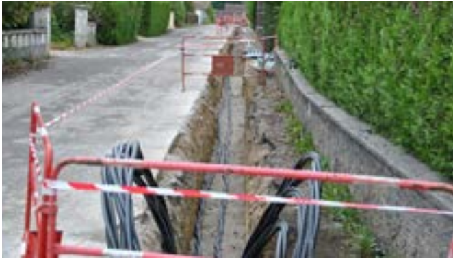
Viabilisation (entreprise Goyard)
