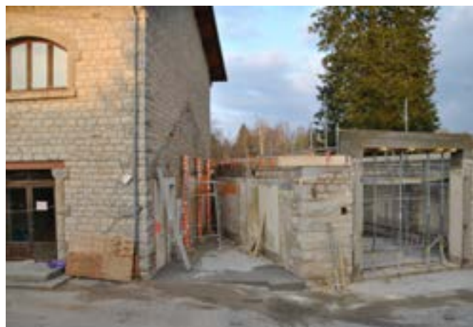
Démontage des WC publics
