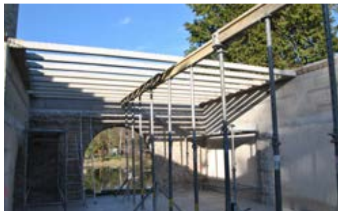
Préparation de la dalle, pour surélévation
