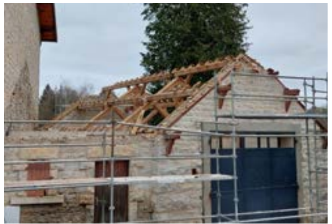
Démontage du toit de la petite salle et du WC public
