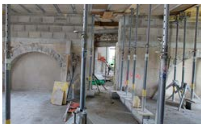
Dalle pour surélévation de la petite salle
